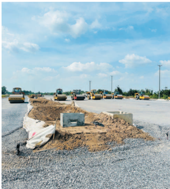
Đẩy mạnh thi công các tuyến đường giao thông tại KCN Phú Thuận
