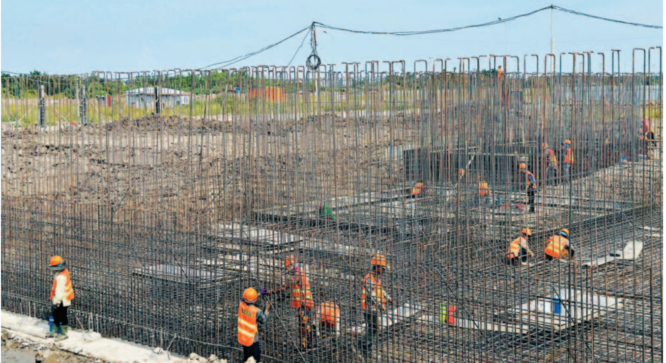
Triển khai thi công Trạm xử lý nước thải 4500m 3 /ngày đêm tại KCN Phú Thuận
