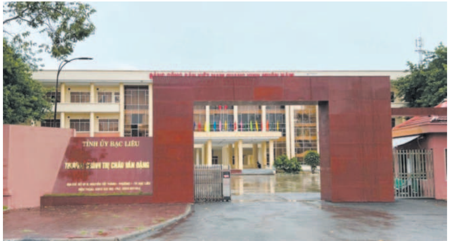
Trong năm 2024, Ban QLDA ĐTXD các công trình dân dụng và công nghiệp tỉnh Bạc Liêu sẽ hoàn thành việc xây dựng, sửa chữa, mua sắm trang thiết bị Trường Chính trị Châu Văn Đăng
